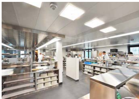
Auf den Neubau der Grossküche im Grand Hotel Dolder ist man bei der Simeta AG besonders stolz. Zwei Jahre dauerten die Montagearbeiten.
